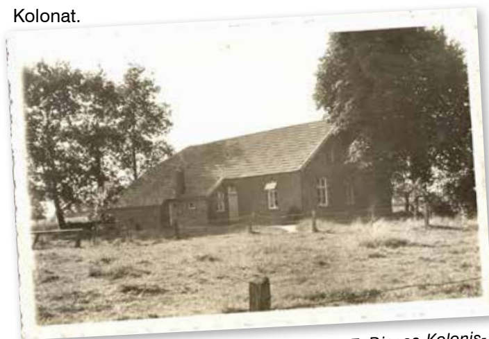
Haus der Familie Take Renken. Baujahr 1907. Dieses Kolonistenhaus war bereits ein Nachfolgebau der ersten Behausung von Take G. Püll., Foto: Repro T. Manssen
